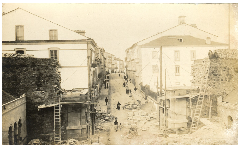
Obras de construción da porta de Emilio Castelar Salvador Castro Freire. 1919
